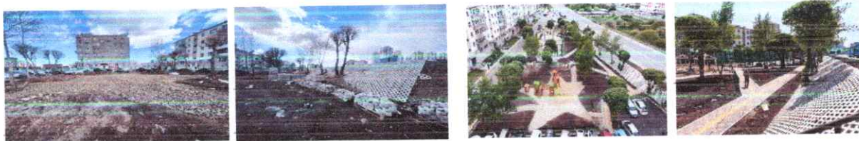
Зураг. Тохижилтын ажлын явц
