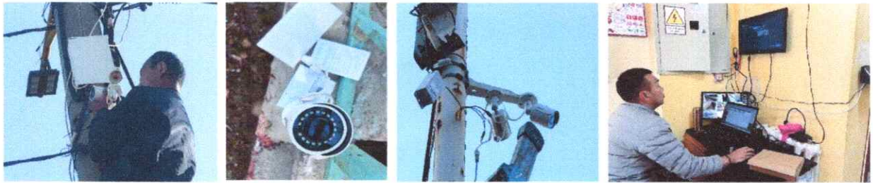
Зураг. Шинээр камер суурилуулах ажил
