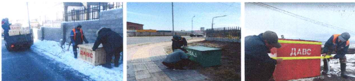
Зураг . Давс, бодисны нөөцийн сав байршуулсан байдал
