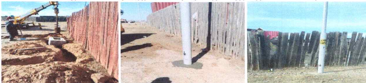
Зураг 27. Хан-Уул дүүрэг, шинээр гэрэлтүүлэг суурилуулах ажлын явц
