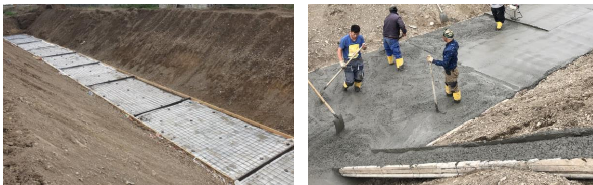
Зураг 7.4. Сувгийн ёроолыг төмөр бетон хийц цутгах
