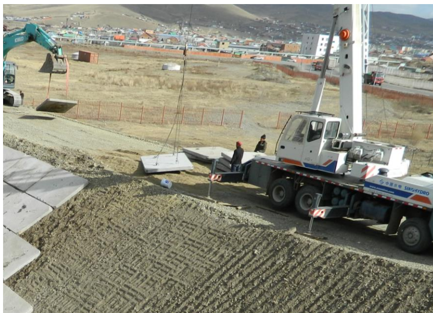
Зураг 7.5. Төмөр бетон хавтан суурилуулж буй байдал
