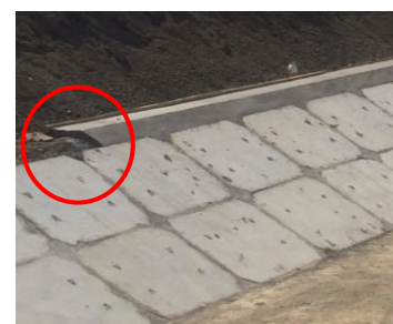
Зураг 7.9. Бетон шүд хийсэн байдал
