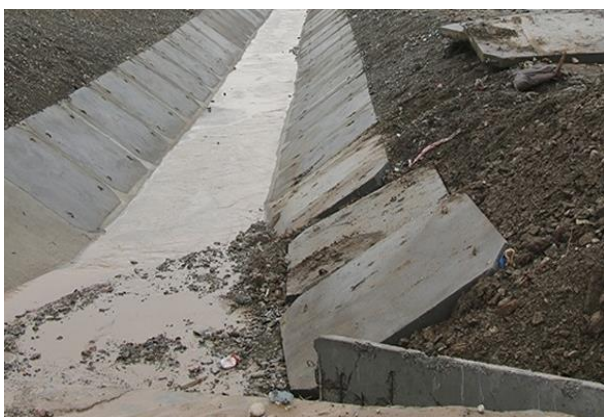
Зураг 14.5. Үерийн хамгаалалтын барилга байгууламжийн засвар, нөхөн сэргээлт
