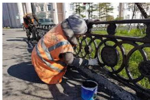
Зураг 6.2. Зам дагуух тусгаарлагч хайсны сэргээн засварлалт
