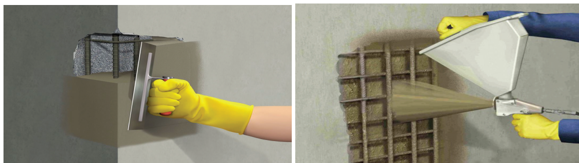
Зураг 12. Арматурыг зэврэлтээс хамгаалах
