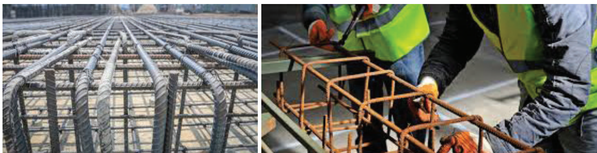
Зураг 11. Арматурын шилбэ суурилуулалт
