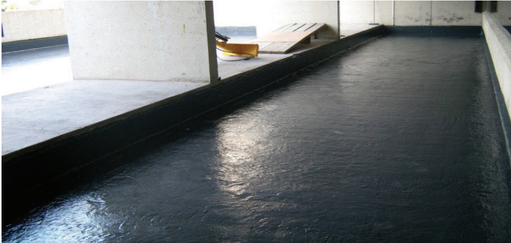
Зураг 4. Барилгын дотор шалны ус тусгаарлалт
