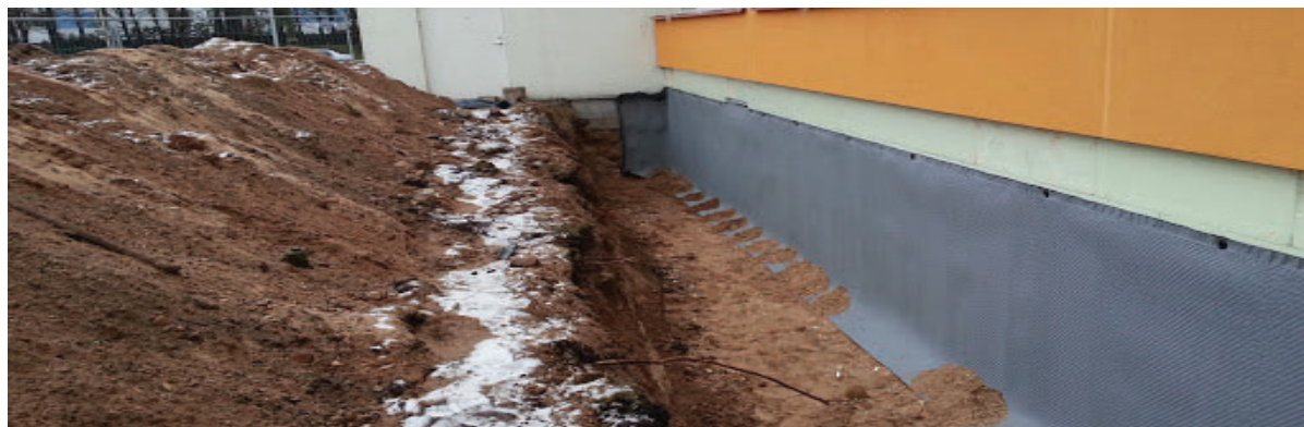
Зураг 9. Металл бүрээсээр ус тусгаарлах
