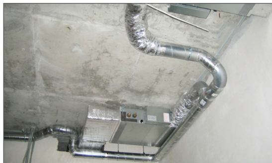
Зураг 15. Салбар шугамуудыг уян хоолойгоор холбосон байдал
