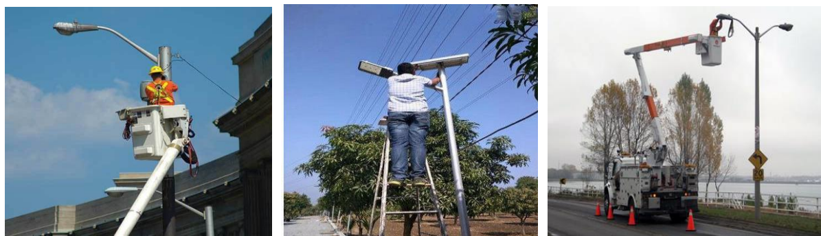
Зураг 20. Нийтийн эзэмшлийн гэрэлтүүлгийн шонд цэвэрлэгээ үйлчилгээ хийж буй байдал
