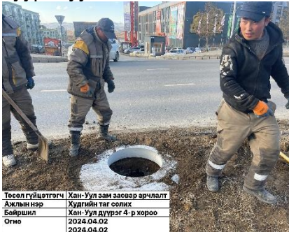
Төсөл гүйцэтгэгч Хан-Уул зам засвар арчлалт Ажлын нэр Худгийн таг солих Байршил Хан-Уул дүүрэг 4-р хороо Огноо 2024.04.02
